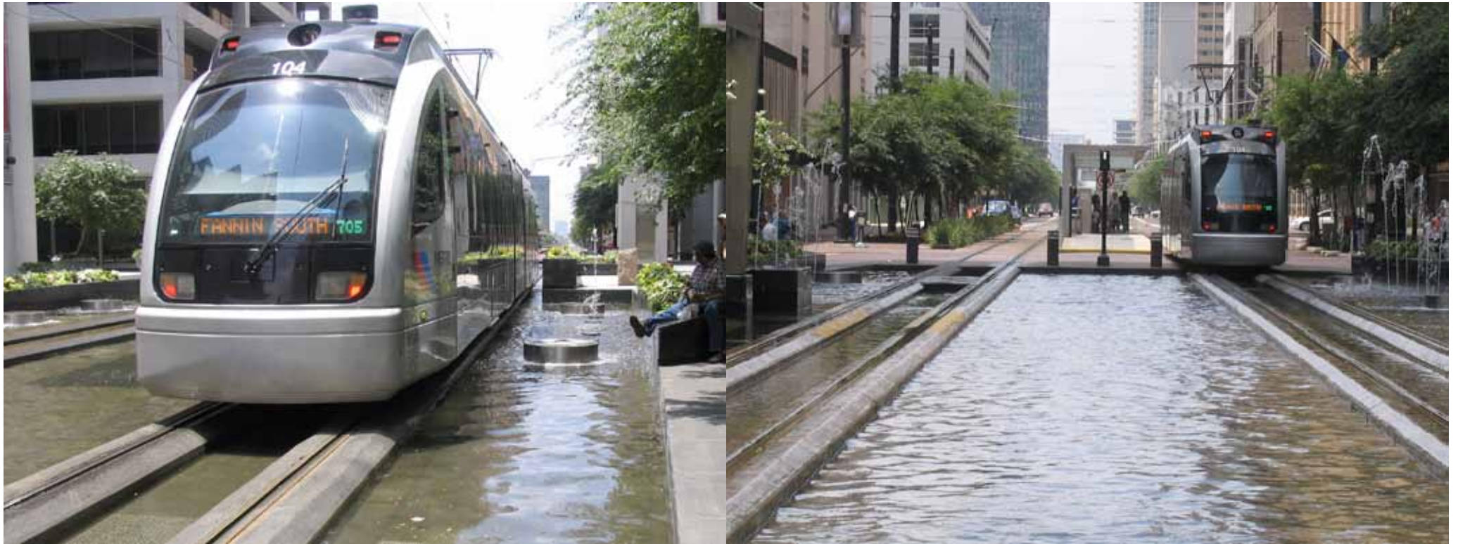
Tracé voor de tram meegekoppeld met water voor een beter binnenstadsklimaat. Houston, Texas, 2007.
